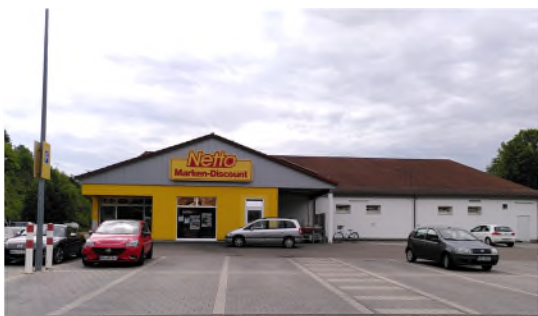
Netto Außenansicht Eingang
