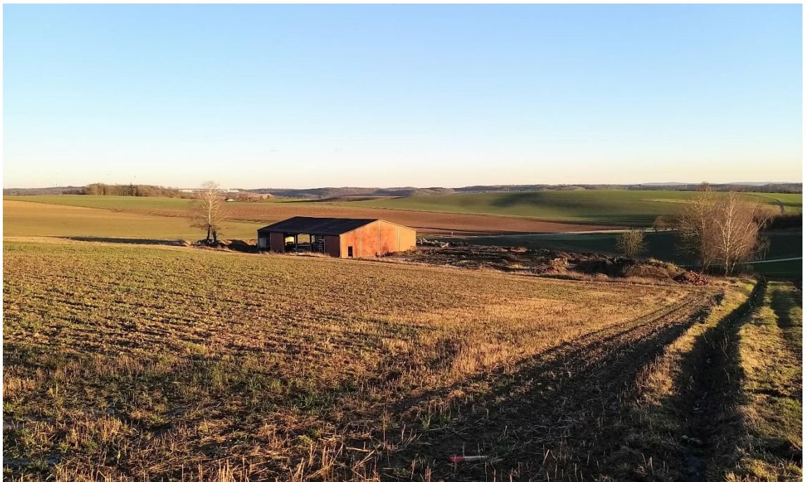
Abb. 4: Blick von Norden auf Bestandsgebäude mit bestehendem Entwässerungsgraben (Quelle: IFK 10.02.2022)
