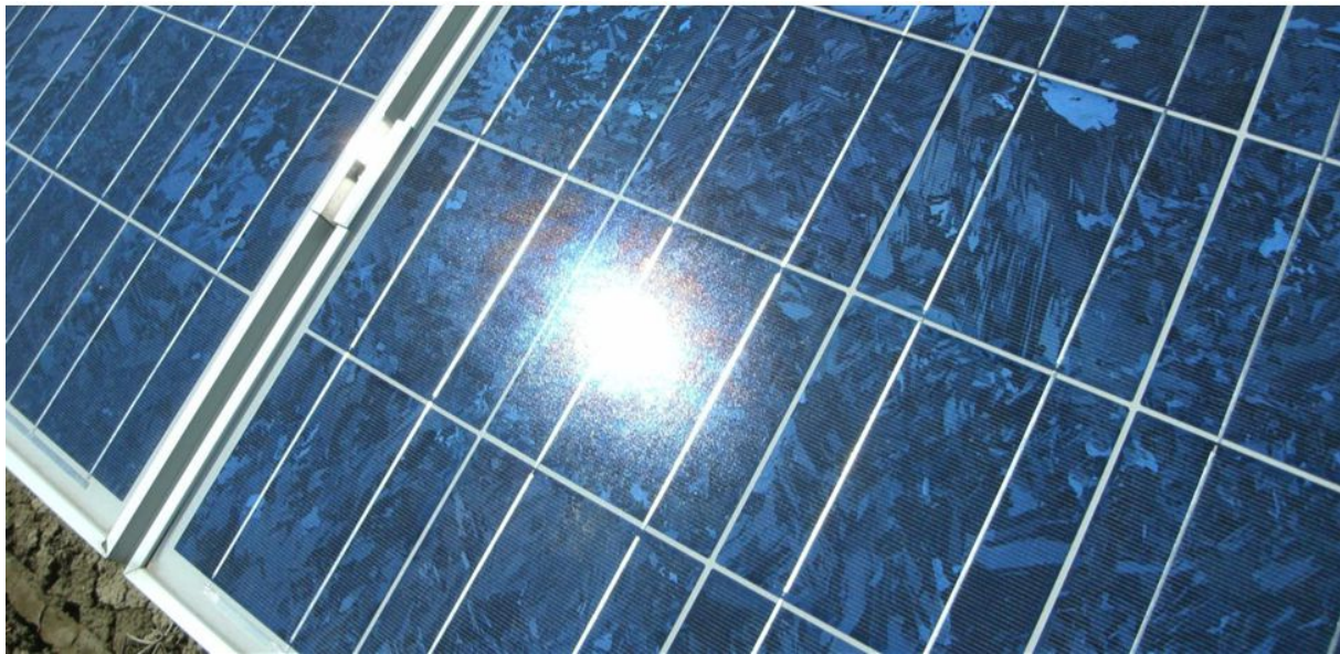
Bild: diffuse Reflexion des Sonnenlichtes an einer PV-Moduloberfläche
