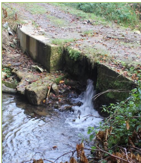
Abb.: Absturz unterhalb der Brücke
