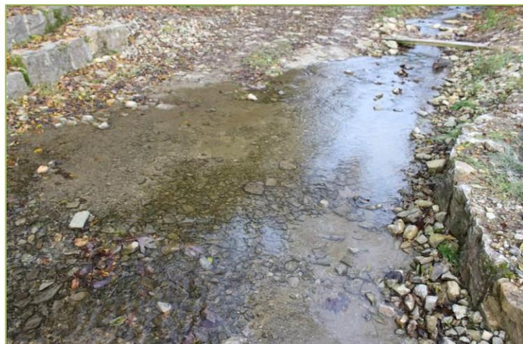
**Abb.:** Substratschicht auf der Überfahrt der Beispielfurt
